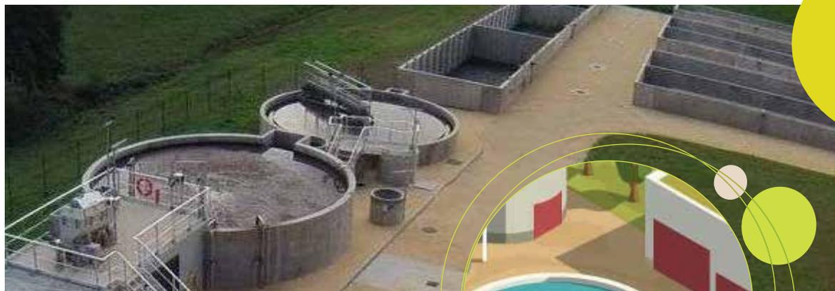
Les réseaux d'assainissement collectif acheminent les eaux usées directement au sein des stations d'épuration. Les effluents traités sont ensuite rejetés dans le milieu naturel.
