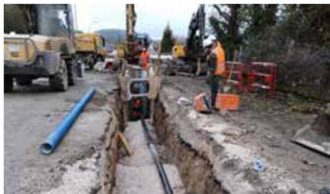
**Réhabilitation du réseau, renouvellement du poste de relevage et refecton de la chaussée principale en cours.**
