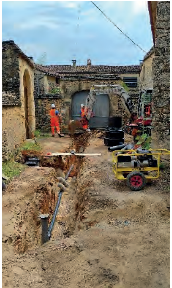
Mise en place du réseau d'assainissement - Baran- Castels et Bézenac
